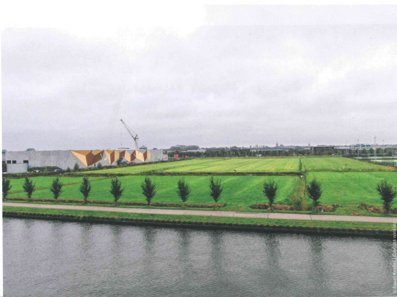
Werffoto tijdens het aanbrengen van de buitenschil. Photo de chantier lors de la pose du revêtement de la façade.
